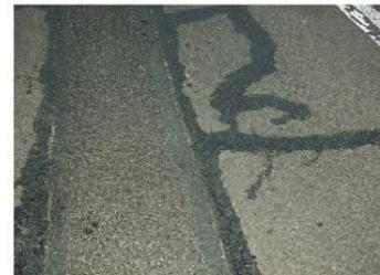
Typické trhlinky na spojích živičných vozovek různého stáří (2x záleváno). I přes ukázané problémy s touto technologií je to zatím nejkalitnější oprava.
