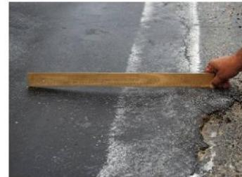
Na obrázku je vidět použití technologie „TLAKOVKA“ na hlubší výtluk. Nastříkaná směs živice a drti se snadno vyjezdí a efekt je špatný.
