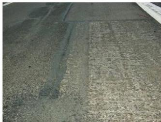
Na tomto snímku jsou dvě provedené opravy rok po sobě. Vidíme vzniklé praskliny, dobrý stav nové živice a rozpadající se starý koberec.
