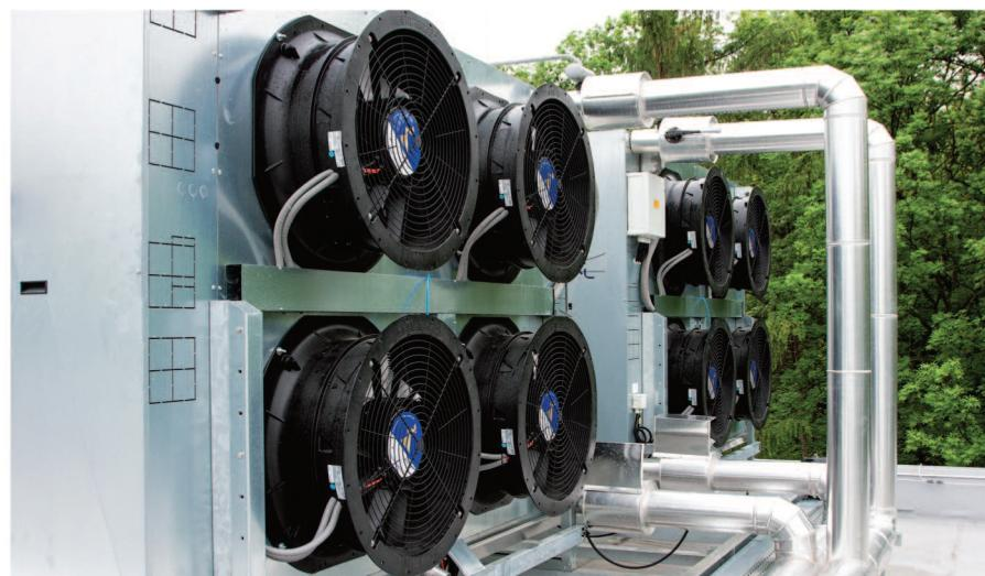
Druhá kaskáda tepelných čerpadel je použita pro výrobu chladící vody pro chlazení laboratoří a klimatizaci administrativních prostor v nadzemních podlažích budovy. Ve spolupráci se soustavou suchých chladičů je tepelnými čerpadly generována chladící voda v teplotním spádu 14/8°C, která je použita pro chladící okruhy vzduchotechniky a konvektorů.
