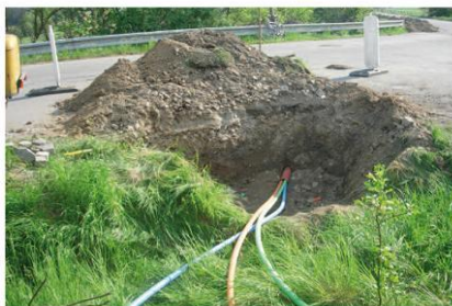
Obr. 3 – Pokládání chrániček v souběhu s výstavbou případně rekonstrukcí silniční sítě – podvrť navazující komunikace FOTO: Petr Pavlinec
