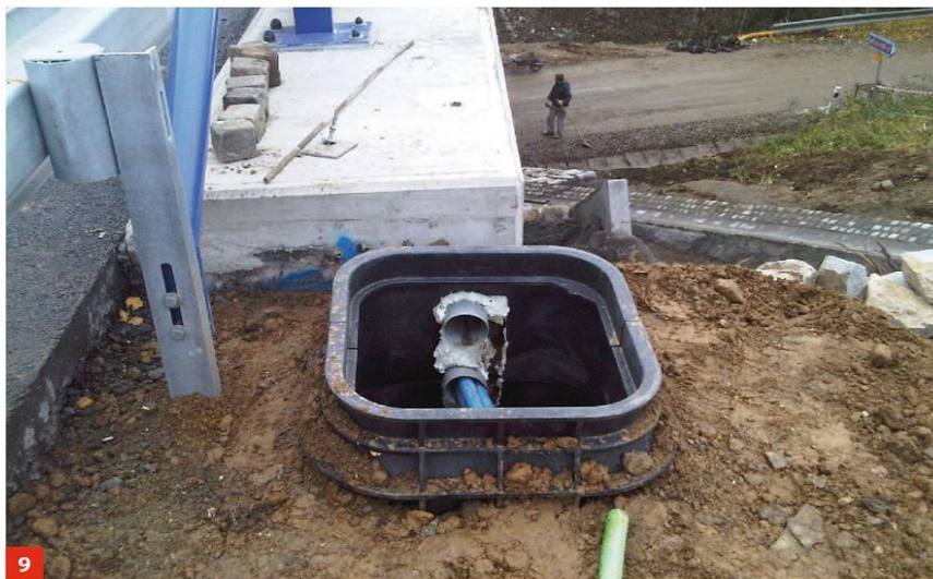
Obr. 10 – Kabelová komora FOTO 8–10: Petr Pavlinec
