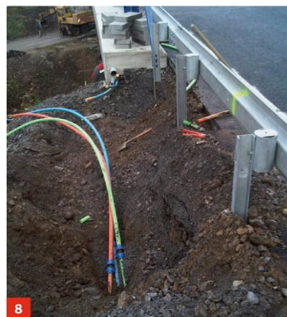
Obr. 7 – Schéma řešení při pokládání chrániček pro optické kabely nedaleko obce Kozlov na Vysočině Krajský úřad Kraje Vysočina
