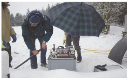
Obr. 4 – „Zafukování“ optického kabelu pomocí kompresoru do chráničky nedaleko Třeště FOTO: Petr Pavlinec
