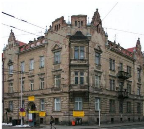
Obr. 3 – Záchrana fasády objektu v památkové zóně. Dům v městské památkové zóně, který postavil v roce 1908 Josef Jihlavec, stavitel podle vlastního návrhu pro klempíře Václava Jirotku, ppl. v.v. Fasády objektu byly v havarijním stavu s destruovanými částmi štítů a plastické výzdoby. Během záchrany fasády byly všechny chybějící prvky doplněny a fasáda byla natřena monochromním nátěrem. Okna zdvojená z doby výstavby tj. roku 1908 byla repasována. Obnova štukových omítek opatřených nátěrem je v současné době dobře zvládnutá, a ačkoliv se jedná o činnost řemeslně náročnou, nedochází při realizaci částečné nebo i kompletní výměny nesoudržných omítek k zániku kulturních hodnot.
