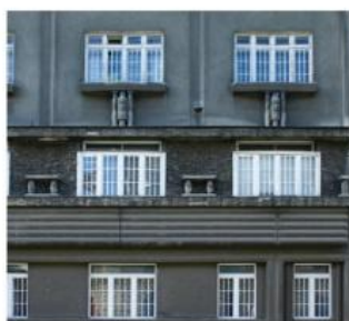
Obr. 4 – Obnova fasády škrábané probarvené ve hmotě na kulturní památce. Dům v městské památkové zóně, který postavil v roce 1913 Josef Jihlavec, stavitel z Hradce Králové jako svůj vlastní dům. Objekt před obnovou fasády (viz obr. vlevo) s poškozenou fasádou, která byla obnovena do „původního“ stavu roku 1913 (viz obr. vpravo). Okna „krystalického“ tvaru byla repasována.
