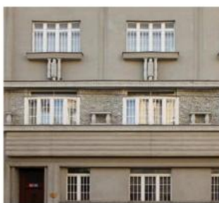
Obr. 4 – Obnova fasády škrábané probarvené ve hmotě na kulturní památce. Dům v městské památkové zóně, který postavil v roce 1913 Josef Jihlavec, stavitel z Hradce Králové jako svůj vlastní dům. Objekt před obnovou fasády (viz obr. vlevo) s poškozenou fasádou, která byla obnovena do „původního“ stavu roku 1913 (viz obr. vpravo). Okna „krystalického“ tvaru byla repasována.
