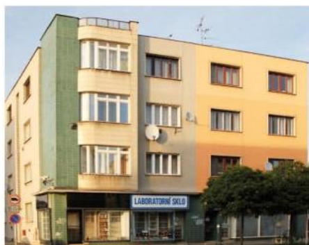
Obr. 2 – Dům na území mimo památkovou ochranu – změna vzhledu. Dům postavený v moderním slohu 30. let 20. století s hladkou škrábanou fasádou bez ozdob, na nároží s obkladem zelené barvy, vystupující, z jedné strany zaoblený arkýř, ostění a nadpraží oken s bílým obkladem. Obklad oken je z tvarovek. Původně ze vzhledu domu nebylo zřejmé, že se jedná o dvě čísla popisná. Na fotografii je zřetelný předěl mezi zateplenou (pravou) částí s jednotlivými horizontálními pásy odstupňovaných odstínů stěrkové omítky zateplovacího systému u výšce podlaží a dosud autentickou částí z doby výstavby (vlevo). Barevnost oken je změněná bez vztahu k rozvrhu fasády a to pouze podle jejich příslušnosti k bytovým jednotkám. Dům je částečně zateplením a změnou barevnosti oken znehodnocen. Objednatel prací a zhotovitel nepochopili architektonickou hodnotu a kompozici objektu a jen mechanicky použili postup často uplatňovaný u panelových domů, při snaze o „rozbití“ plochy jejich fasád barevnými pásy. 11
