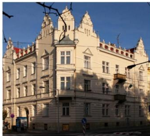
Obr. 3 – Záchrana fasády objektu v památkové zóně. Dům v městské památkové zóně, který postavil v roce 1908 Josef Jihlavec, stavitel podle vlastního návrhu pro klempíře Václava Jirotku, ppl. v.v. Fasády objektu byly v havarijním stavu s destruovanými částmi štítů a plastické výzdoby. Během záchrany fasády byly všechny chybějící prvky doplněny a fasáda byla natřena monochromním nátěrem. Okna zdvojená z doby výstavby tj. roku 1908 byla repasována. Obnova štukových omítek opatřených nátěrem je v současné době dobře zvládnutá, a ačkoliv se jedná o činnost řemeslně náročnou, nedochází při realizaci částečné nebo i kompletní výměny nesoudržných omítek k zániku kulturních hodnot.
