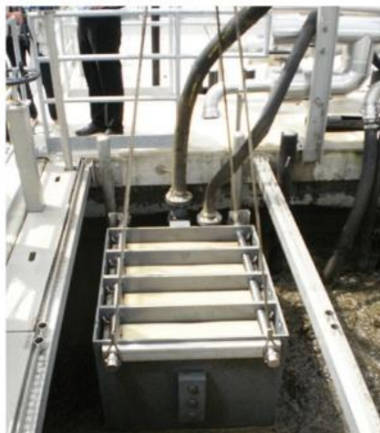
Membránový modul a jeho napojení na sací potrubí
