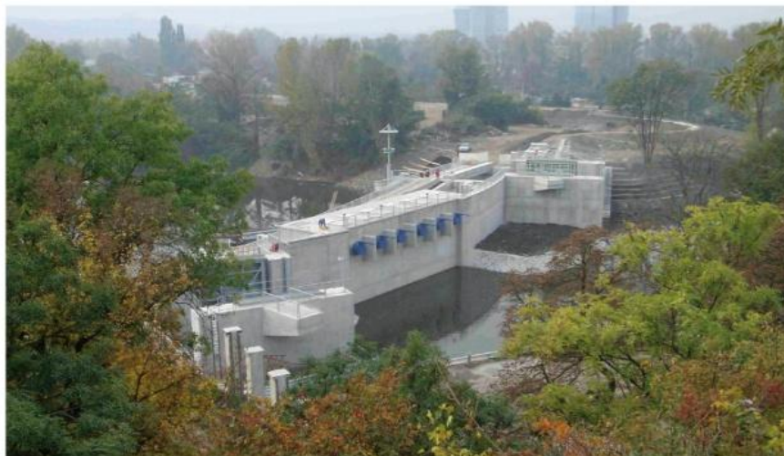
Obr. 7 – Dvojice vzpěrných vrat a povodňová čerpací stanice v Libeňských přístavech
