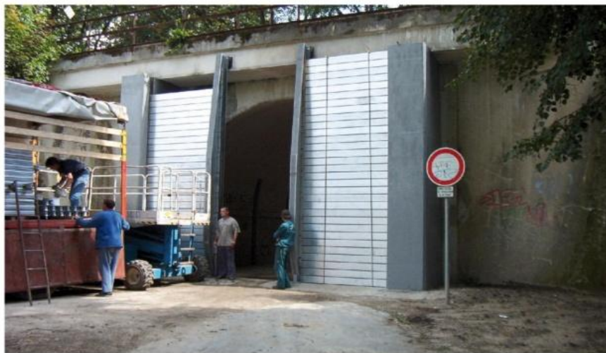
Obr. 8 – Hrazení podjezdu železničního náspu kolem Stromovky
