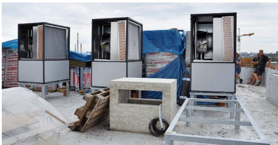
Příklad instalace REHAU TČ na střechu
