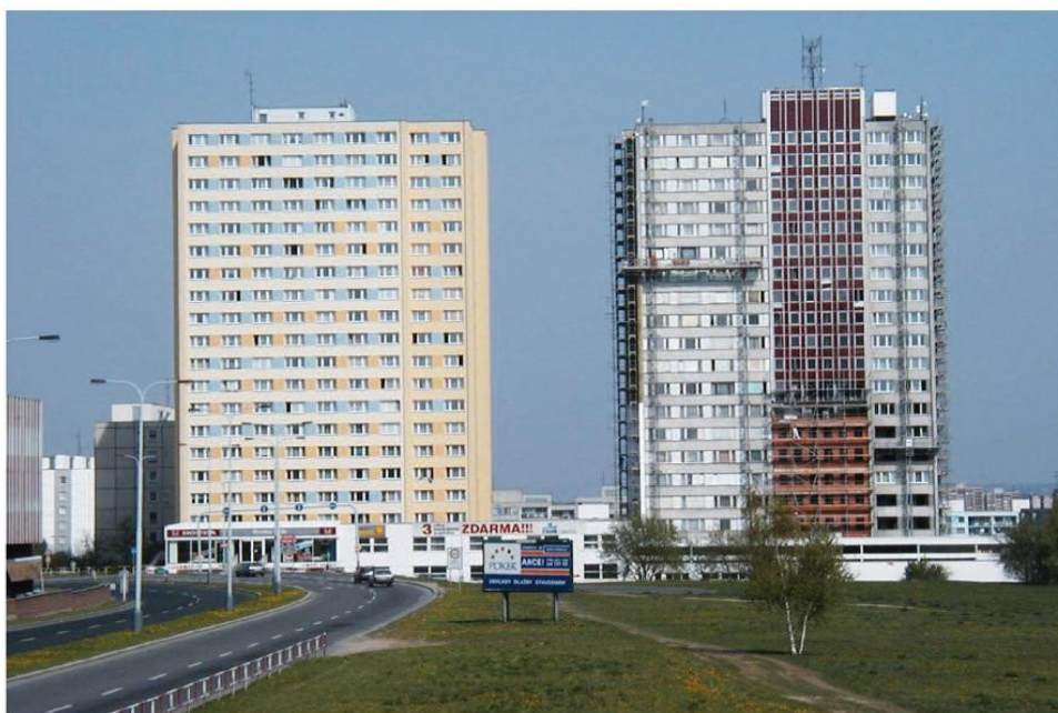
Příklad omezeného prostoru na střechách panelových domů
