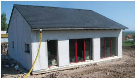
Obr. 6 – Pasivní přízemní RD 121 m² zastavěné plochy s 15 kWh/m²rok na samé hranici možnosti dosažení PD v ČR.
