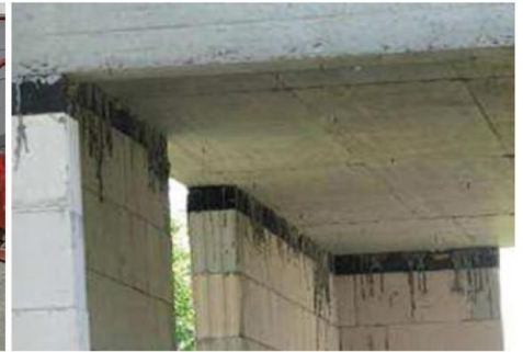
Obr. 7 – Správné řešení detailu napojení vodorovné a svislé izolace pomocí KS-ISO Kimmsteine v úrovni podlahy nebo pomocí deskového pěnoskla v úrovni stropu nad nevytápěnou garáží. Vynechání pěnoskla nebo jiného izolantu v tomto detailu by bylo vážnou projekční chybou.
