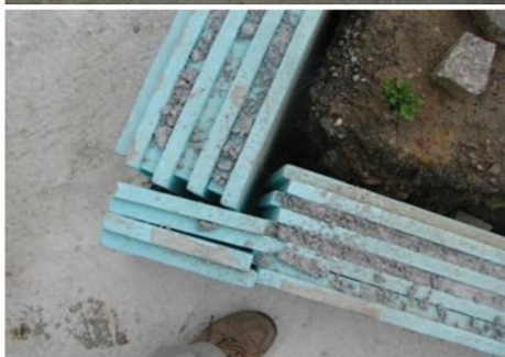
Obr. 10 – Provedení svislé izolace základů se značnými nerovnostmi, izolace na sebe nenavazují, do spár se dostává beton, hlína, vznik tepelných mostů. Navíc nebyla použita správná tl. izolace, ale místo toho nahrazena čtyřmi slabšími deskami. Na další fotografii provedení trojúhelníkový štítek z vápenopískového zdiva tvoří tepelný most, protože tepelná obálka probíhá na ŽB stropě. Štítek měl být proveden z OSB desky. Tady buď opraveno tím, že celý štítek bude kolem dokola izolován vč. horní hrany štítku – viz obrázek.
