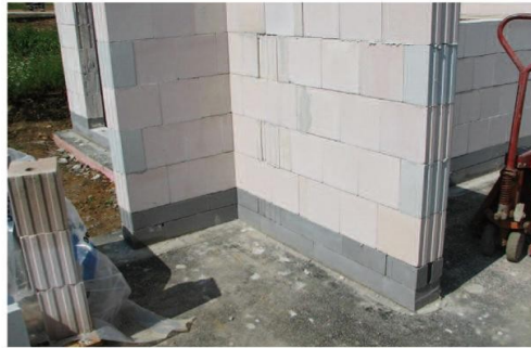
Obr. 7 – Správné řešení detailu napojení vodorovné a svislé izolace pomocí KS-ISO Kimmsteine v úrovni podlahy nebo pomocí deskového pěnoskla v úrovni stropu nad nevytápěnou garáží. Vynechání pěnoskla nebo jiného izolantu v tomto detailu by bylo vážnou projekční chybou.
