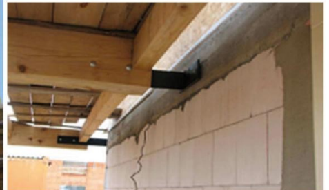
Obr. 8 – Příklady ocelových kotev, které skrz masivní tepelnou izolaci budou tvořit významné tepelné mosty. Řešení těchto detailů je špatně neprojektované.
