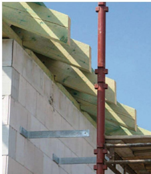
Obr. 8 – Příklady ocelových kotev, které skrz masivní tepelnou izolaci budou tvořit významné tepelné mosty. Řešení těchto detailů je špatně neprojektované.
