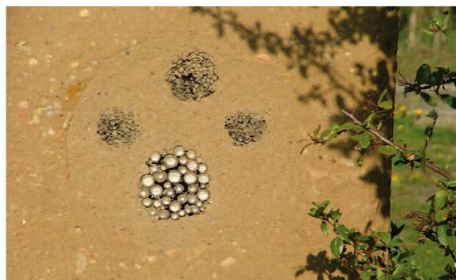
Obr. 6 – Venkovní hliněná omítka se zabudovanými úkryty pro hmyz.
