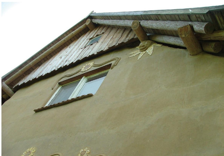
Obr. 4 – Slaměný dům s venkovními hliněnými omítkami
