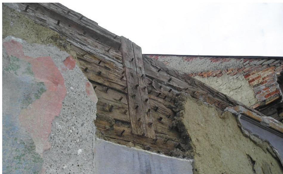
Obr. 1 – Souvrství omítek na srubové stavbě. Spodní tlustou vrstvu tvoří hliněná omazávka se slaměnou řezankou, jejíž přídržnost ke dřevu je zajištěna tzv. ježkováním. Na ní jsou uloženy dvě vrstvy hrubé hliněné omítky s pleví. Závěrečnou vrstvu tvoří vápenná omítka překrytá několiknásobně různobarevnými vrstvami barevných vápenných nátěrů.
