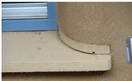
Obr. 5 – Velmi zdařile provedený detail napojení parapetu na hliněnou omítku.
