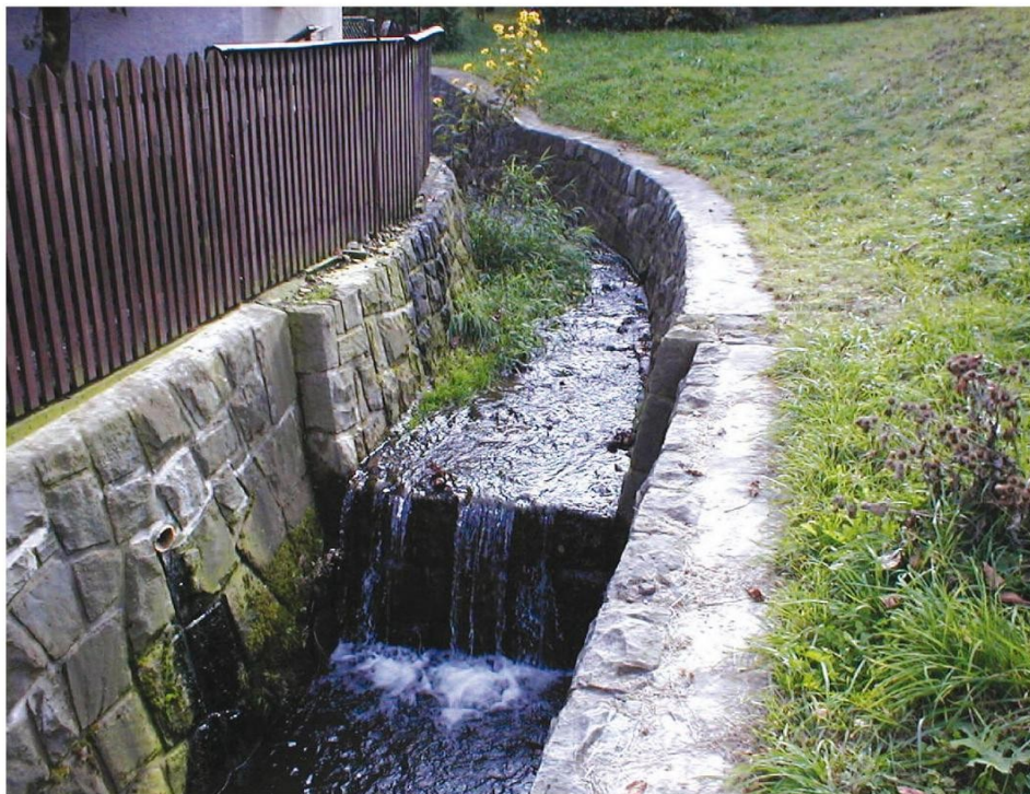
Obr. 2 – I spádový stupeň je migrační překážkou na toku. Potok v oblasti Beskyd
