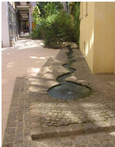
Výtvarný prvek pro rozvod dešťových vod
