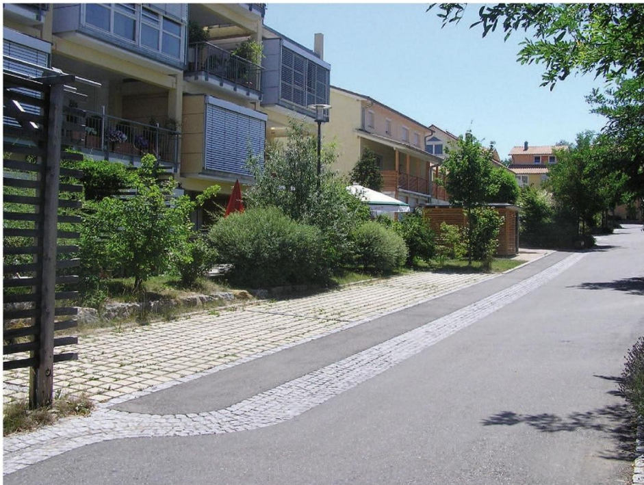
Odvod dešťových vod žlabem v komunikaci
