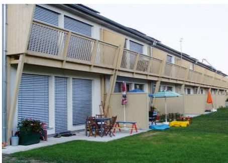
Obr. 8 Židlochovice – pasivní domy z pórobetonových tvárníc
