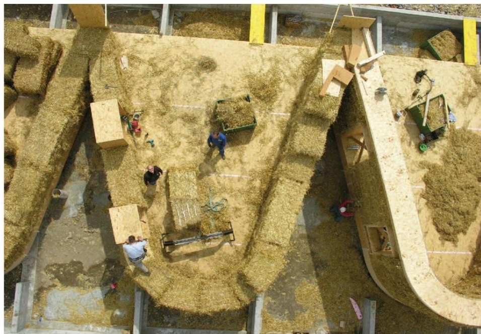
Obr. 14 Lana (I) – výstavba hrubé stavby pasivního domu z nosné slámy
