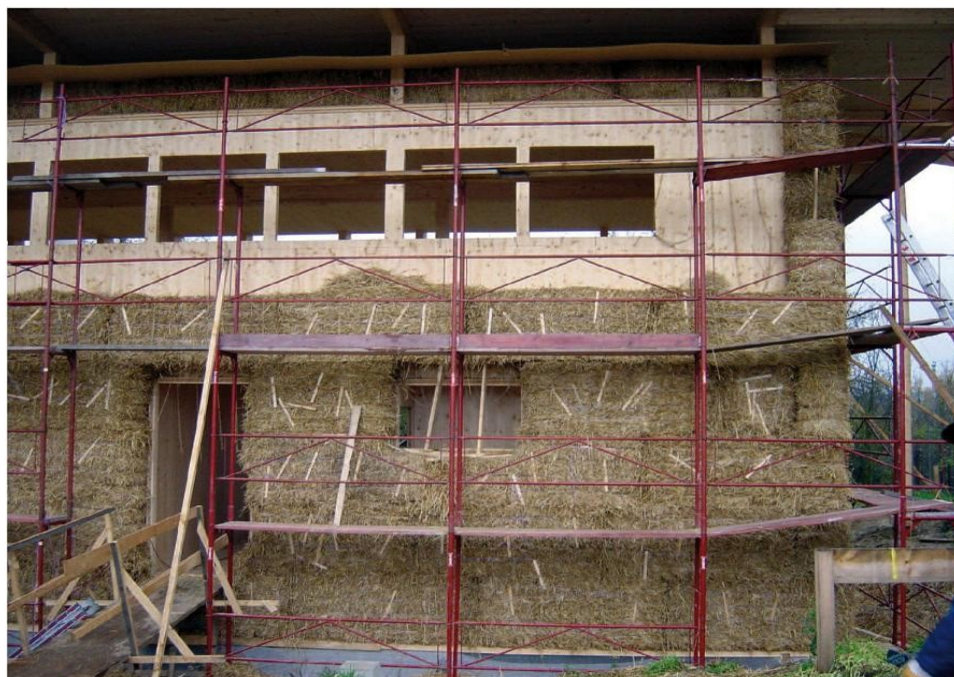
Obr. 13 Böhheimkirchen (A) – vertikální nosná konstrukce z desek KLH s tepelně izolační vrstvou ze slaměných balíků Autor: arch. Hans W. Scheicher Foto: GrATTU Wien
