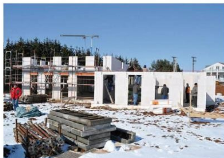
Obr. 6 Neukirchen (D) – dvoupodlažní pasivní solární dům budovaný s nosnými stěnami z vápenopískových bloků tloušťky 175 mm
