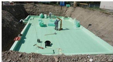
Obr. 3 Augsburg (D) – izolování základů pomocí izolace z XPS Autor a foto: arch. Werner Friedel
