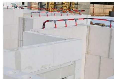
Obr. 7 Neukirchen (D) – stěnové topení s rozvodou ve vertikálních dutinách vápenopískových bloků KS-QUADROTHERM
