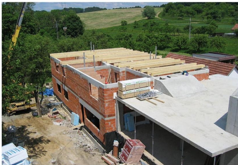
Obr. 4 Hostětín – hrubá stavba pasivního domu s cihelným zdivem tl. 175 mm Autor: arch. Georg W. Reinberg Foto: Ekologické centrum Veronica Brno
