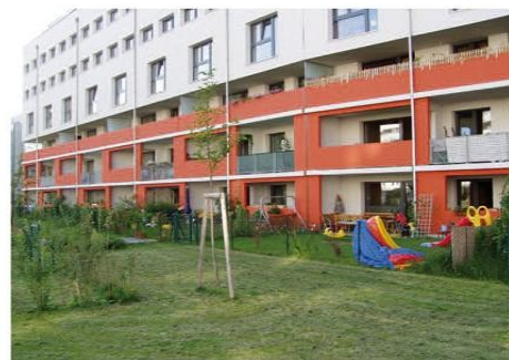
Obr. 9 Vídeň (A) – průčelí pasivního obytného domu ze železobetonu
