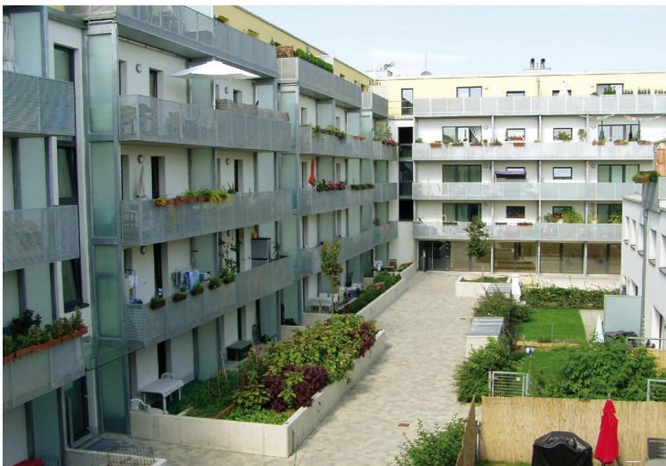
Obr. 10 Vídeň (A) – atrium pasivního obytného domu ze železobetonu
