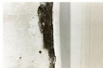
Obr. 3 – Odstranění olejového tmelu od ostění
