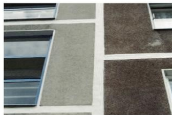
Obr. 11 – Oprava spár překrytím
