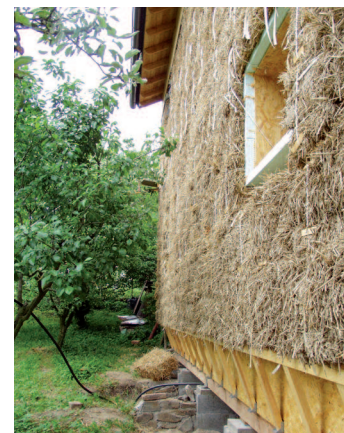
Slaměné balíky jsou přivazovány k dřevěné konstrukci, prostor za nimi je vyfoukán celulózou.
