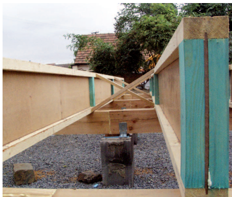
Základové patky jsou úspornější variantou pasových základů a betonové desky. Na nich stojí roznášecí modřínový práh a dřevěné I nosníky zavěšené proti klopení, které tvoří rošt pro izolaci.
