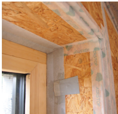
Osazení okna do konstrukce stěny v OSB kastlíku se zaobleným ostěním z tvarovek EPS. Vzduchotěsné napojení je u přírodních staveb naprosto zásadní.
