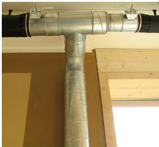
Větrací jednotka s rekuperací tepla včetně zemního výměníku. Alternativy ke kovovým rozvodům mohou být textilní nebo dřevěné rozvody.
