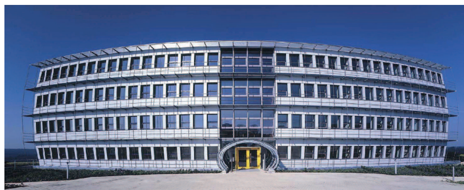
Obr. 4 – Nejen správná volba rámu a zasklení, ale zejména velikost a umístění zásadně ovlivňuje spokojenost uživatelů. Pěkný příklad rozumné míry prosklení u administrativní budovy Energon v německém Ulmu. Naproti celoproskleným fasádám „moderních“ administrativních budov jsou teploty v interiéru vyváženější a napomáhá tomu i precizní stínění slunolamy a automaticky ovládanými žaluziemi. Okna s parapetem také umožňují lepší využití vnitřního prostoru a nepřinášejí zbytečné solární zisky bez vlivu na prosvětlení interiéru. (zdroj: oehler faigle archkom)
