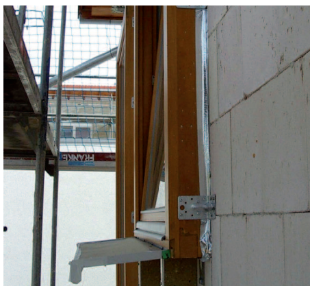
Obr. 5 – Špatný příklad okna (vlevo) s porušením všech principů správného osazení. Okno je podloženo plynými cihlami procházejícími ven, bez použití těsnících materiálů a s nekorektním použitím kotvicích prostředků. Naproti tomu pěkný příklad předřazené montáže okna (vpravo) do roviny tepelné izolace s použitím těsného napojení na konstrukci.
