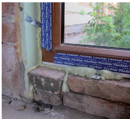
Obr. 5 – Špatný příklad okna (vlevo) s porušením všech principů správného osazení. Okno je podloženo plynými cihlami procházejícími ven, bez použití těsnících materiálů a s nekorektním použitím kotvicích prostředků. Naproti tomu pěkný příklad předřazené montáže okna (vpravo) do roviny tepelné izolace s použitím těsného napojení na konstrukci.
