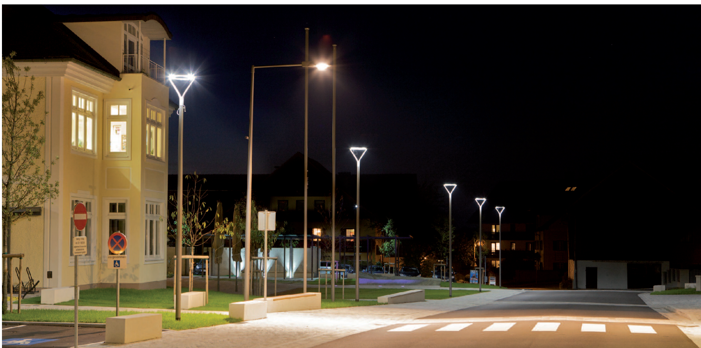
Obr. 1 – neviditelná virtuální síť... řídí dopravu, zabezpečuje budovy... obecní i privátní... pozorný a pravidelný čtenář si jistě povšiml, že přechod je osvětlen zdrojem s teplejší barvou (vysokotlakých sodíkových výbojek) než ulice (LED)
