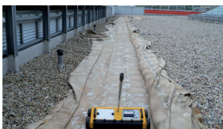
Obr. 3 – Induktační skenování v rozkrytých koridorech zatěžovací vrstvy
