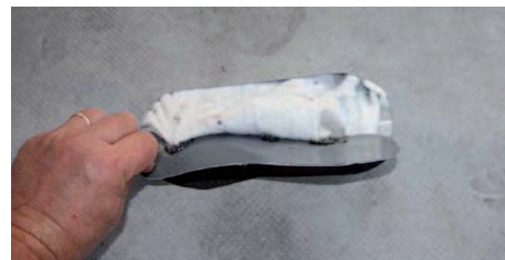
Obr. 13 – Rubová strana fólie, kde je jasně patrné propenetrování asfaltu skrz tenkou separační textilii
