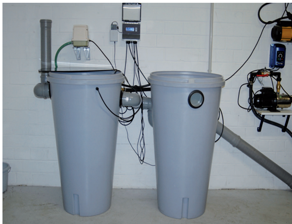
Kompaktní čistírna šedých vod pro rodinné i bytové domy.
