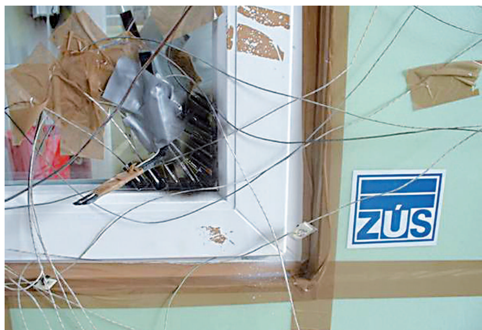
Obrázek č. 7 umístění čidel v rohu okenní konstrukce.
