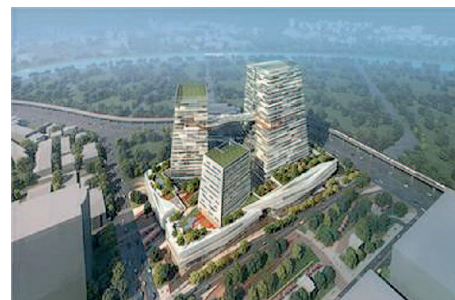
Ústředí Chinatrust Bank Taiwan- NBBJ
