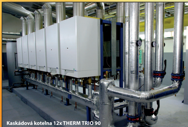
Kaskádová kotelna 12x THERM TRIO 90
