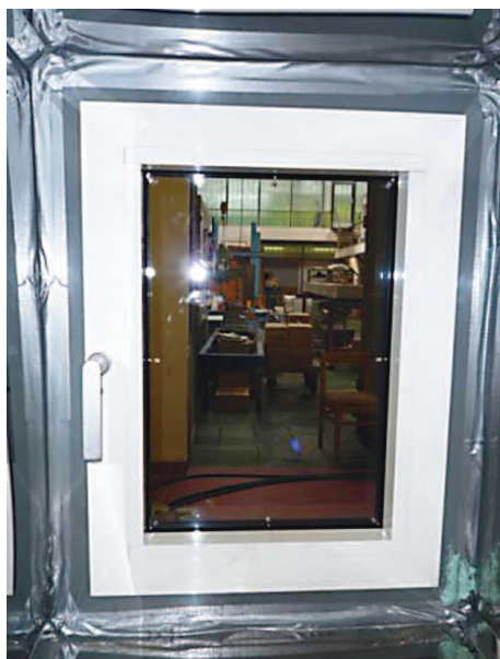
Obrázek č. 4 – osazení okenní konstrukce – zamezení infiltrace.
