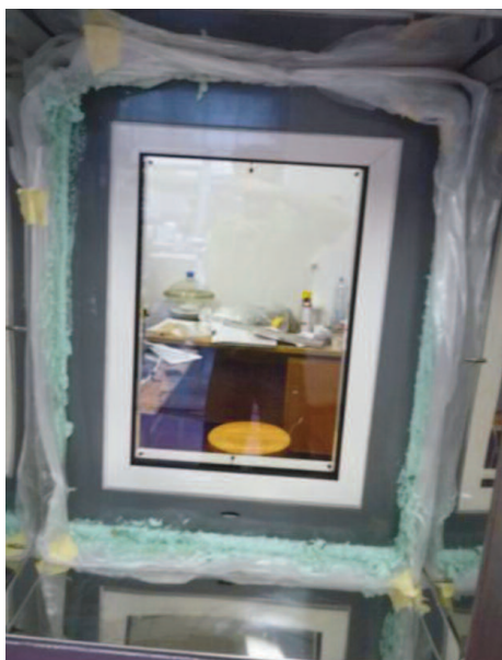
Obrázek č. 3 – osazení okenní konstrukce – tepelná izolace.
