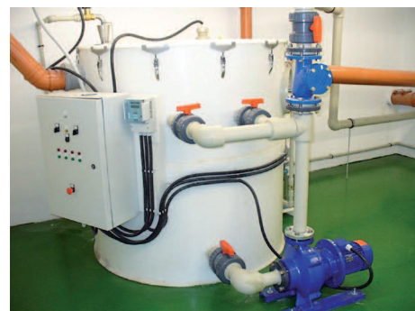
Obr. 2: Lapák tuků typu AS-FAKU FOZ AUTO
