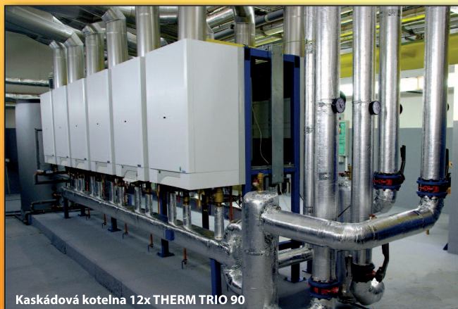
Kaskádová kotelna 12x THERM TRIO 90
