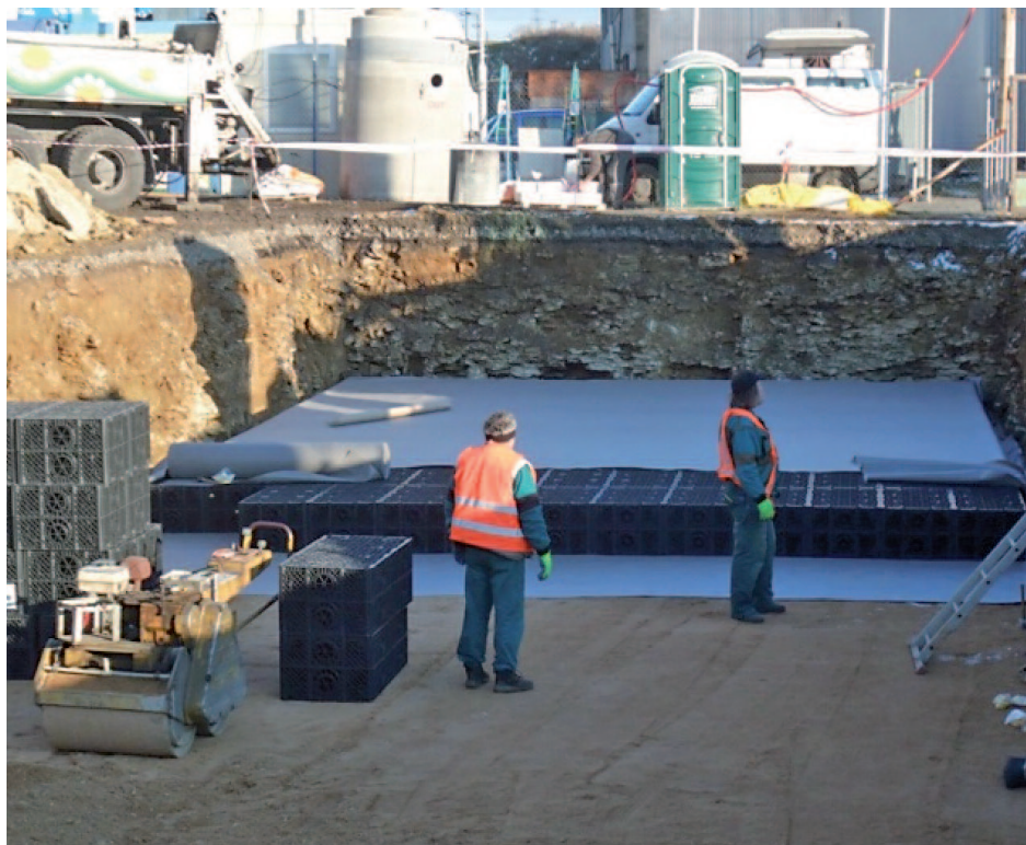
Obr. č. 4 – podzemní vsakovací objekt z vsakovacích bloků ve výstavbě
