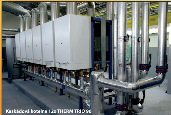
Kaskádová kotelna 12x THERM TRIO 90
