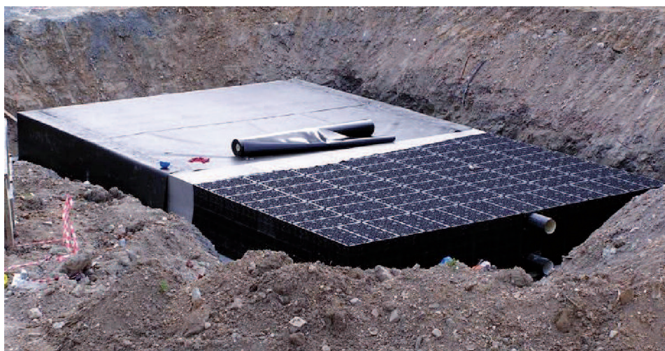
Obr. 5 – retenční nádrž ve výstavbě
