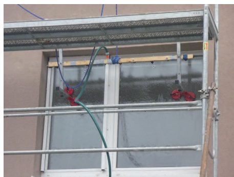
6 – Skúška vodotesnosti okna
